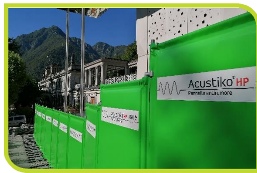
Cantiere ampliamento Terme San Pellegrino
